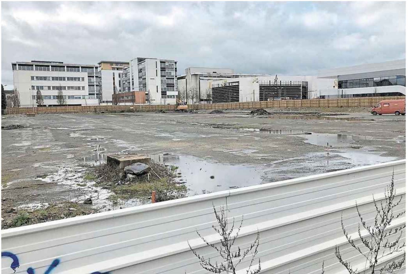
Angers, rue René-Rouchy, 2 mars. C'est sur ce terrain vague que les travaux de terrassement du projet Métamorphose ont démarré. PHOTO : COO-ANTHONY PASCO
